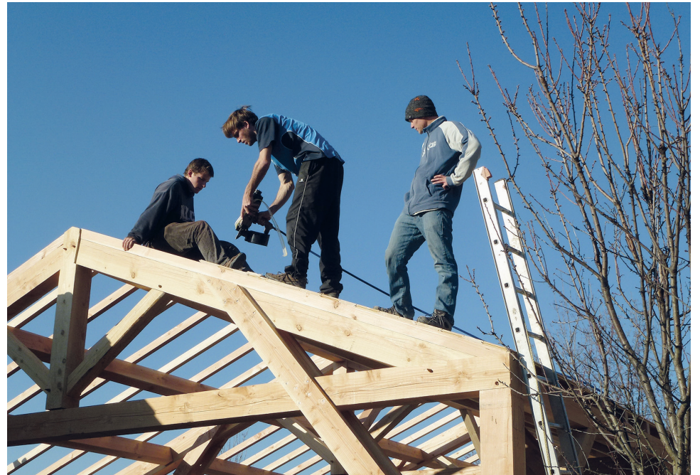
Une équipe des jeunes monte la charpente pour le nouvel atelier textile à Limans, Provence
