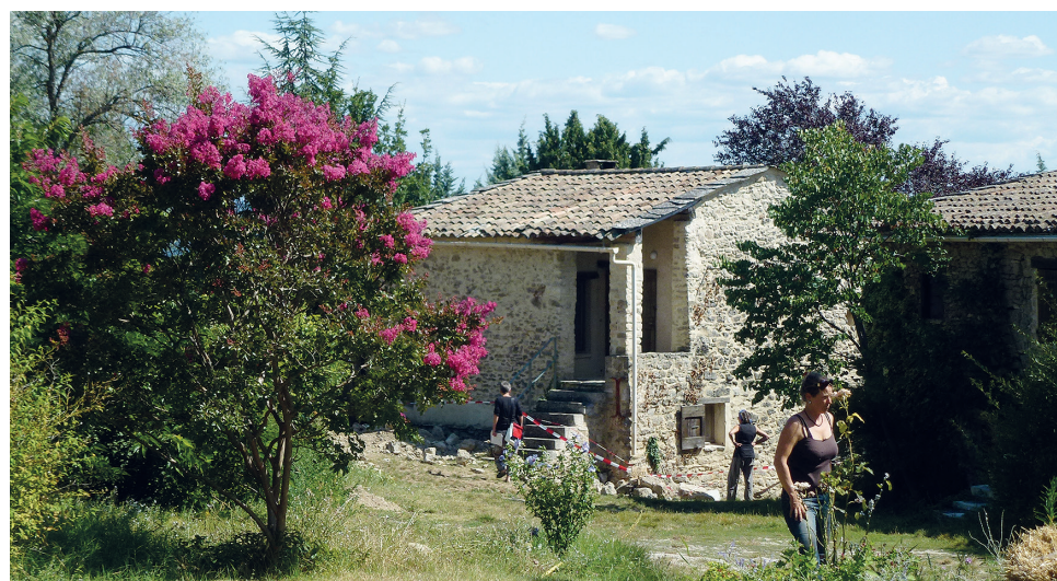
Une des maisons individuelles des Magnans en cours de restauration.
