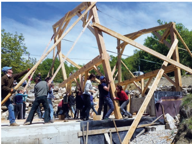
La mise en place de la charpente pour la «Nouvelle Maison» demande beaucoup de bras.
