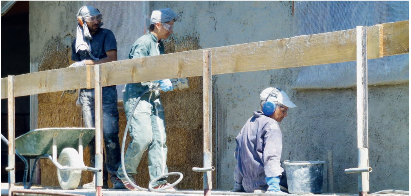
Le chantier de la nouvelle maison commune. La chaux demande une bonne protection.
