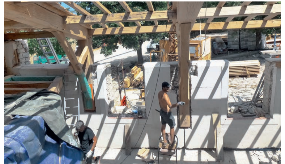
La salle commune de Grange Neuve est en cours de rénovation de la tête aux pieds.
