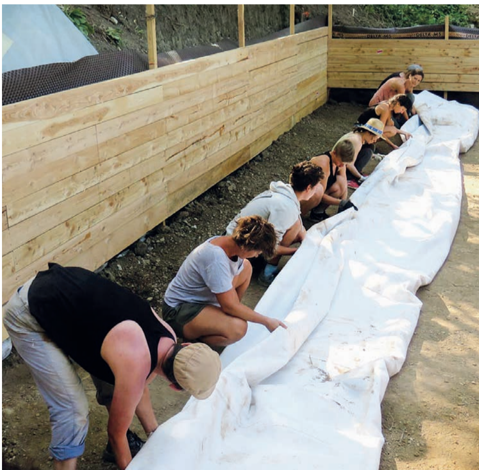
«Girl power»: pose de la bâche pour la phytoépuration.
