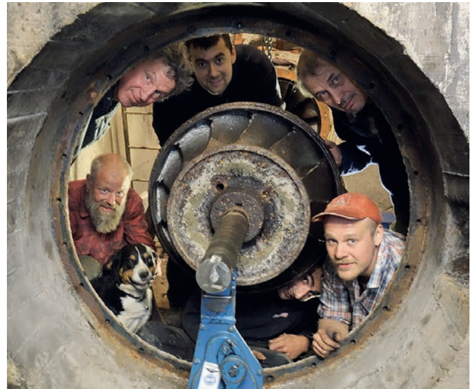
Stage de formation sur le chantier de la nouvelle turbine de la Filature.
