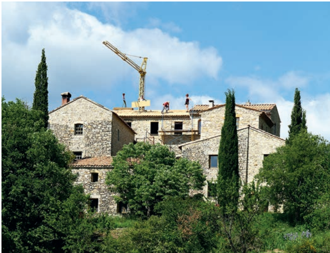
Le centre de l'école se trouvera dans le hameau de St. Hippolyte en Provence.
